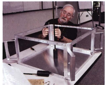
Obr. 3. Jeden z hlavních aktérů projektu: Lou McFadin, W5DID, při montáži skeletu družice
